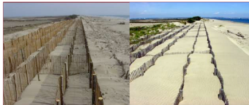
Ouvrage de réhabilitation dunaire en Occitanie en 2005 lors de l'installation, puis en 2011. (Source : Hugues Heurtefeux)
